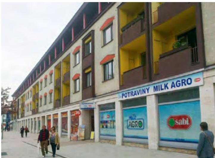
Panelákové centrum mesta Vranov nad Topľou
